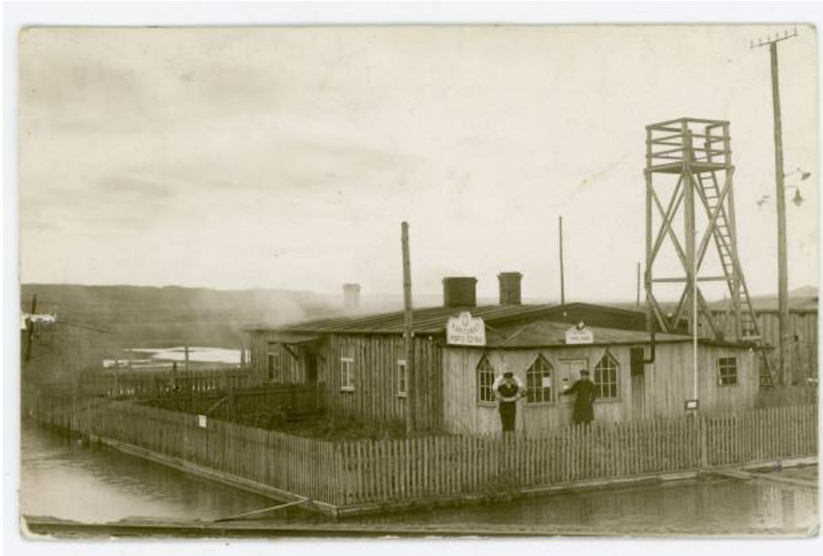
Pierwszy (drewniany) budynek kapitanatu portu w Gdyni
