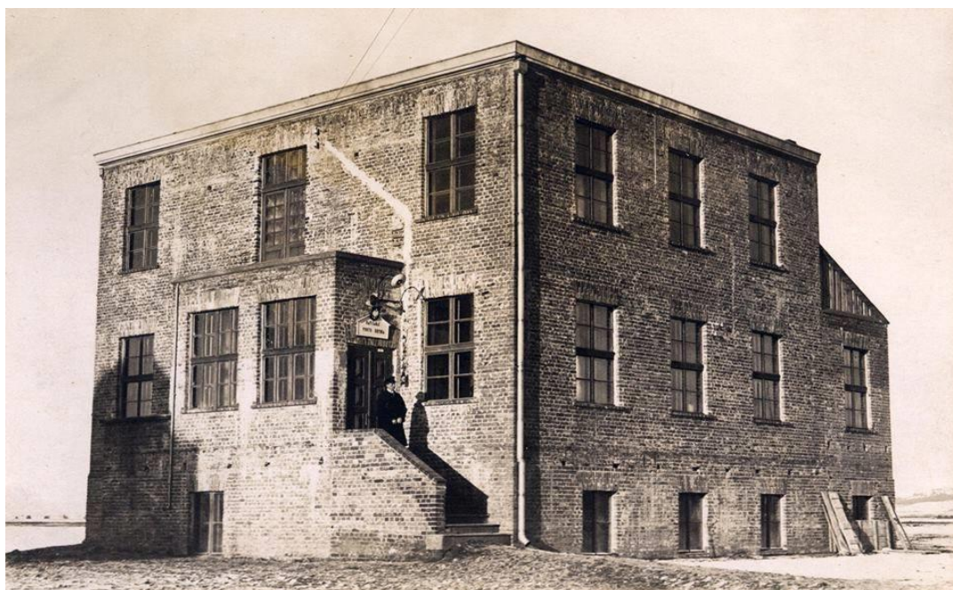
Druga siedziba Kapitanatu mieściła się w południowym skrzydle obecnego Urzędu Morskiego do którego w 1927 dobudowano całą resztę. Wtedy do nowego gmachu przeniesiono z Wejherowa Urząd Marynarki Handlowej.
